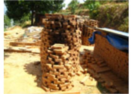
Zum Bau von Gebäuden, sowie der Öfen und Kamine im Außen wurde mit der Herstellung von Ziegeln begonnen. Diese werden aus einem Lehn-Sandgemisch händisch und mit einer kleinen Ziegelmaschine hergestellt und dann luftgetrocknet. Nun wurden die ersten Ziegel-Brenn-Öfen gebaut, um die luftgetrockneten Ziegel langlebiger zu machen und damit sie sich im Monsun nicht auflösen. Dies sind die ersten Ziegel, die in dieser Gegend gebrannt werden.
